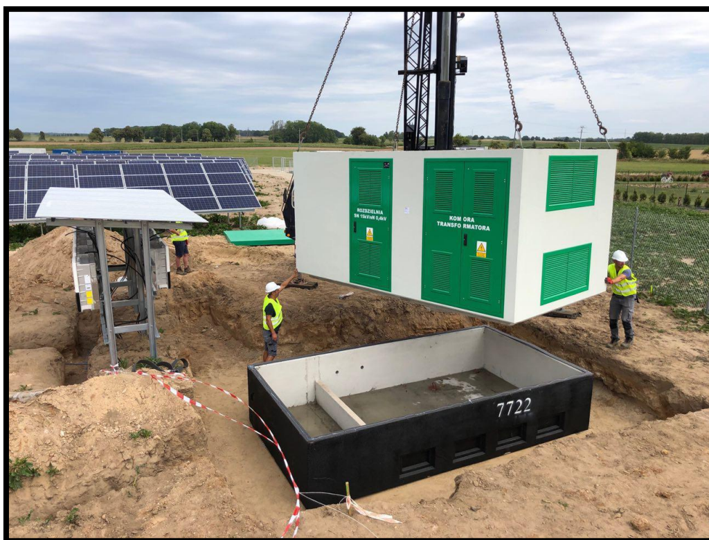
Zdj. 5 Posadowienie stacji transformatorowej
