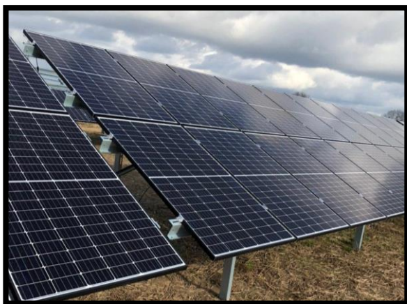
Zdj. 1 Monokrystaliczne panele fotowoltaiczne
