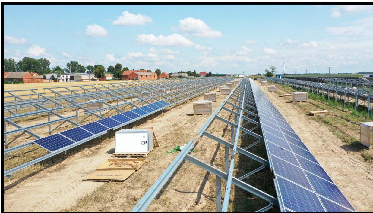
Zdj. 3 Konstrukcja wsporcza (farma słoneczna Ziemin, gm. Krobia)
