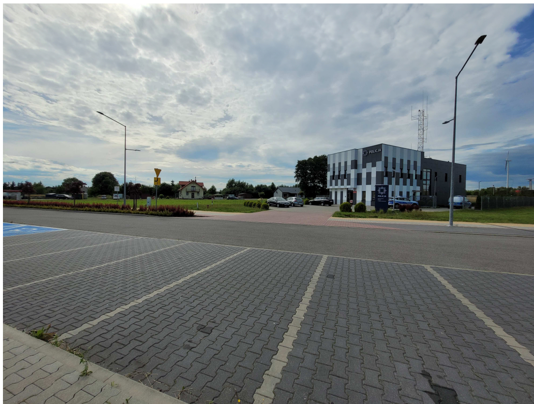
Fot. 6. Posterunek policji oraz zabudowania mieszkalne jednorodzinne przy ul. Warszawskiej.
