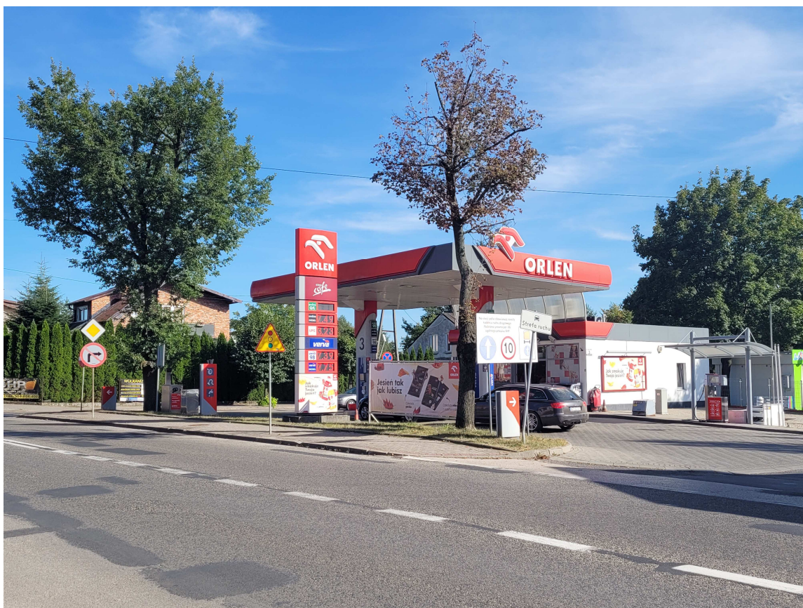
Fot. 10. Stacja paliw przy ul. Warszawskiej, 3-go Maja i G. Narutowicza.
