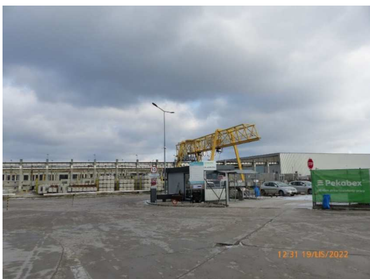
Fot. 36,37. Widok na Obszar nr 15 położony wzdłuż ul. Grójeckiej w miejscowości Badowo Mściska.
