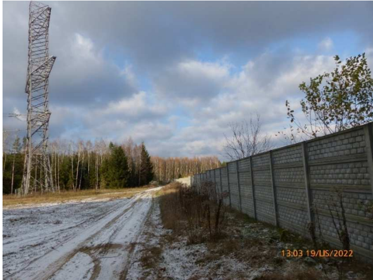
Fot. 43,44. Widok na Obszar nr 19 od ul. Środkowej w miejscowości Lutkówka Druga.
