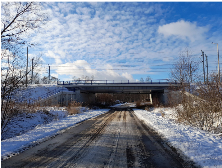
Fot. 16. Widok na wiadukt kolejowy nad ciągiem drogi publicznej klasy lokalnej.
