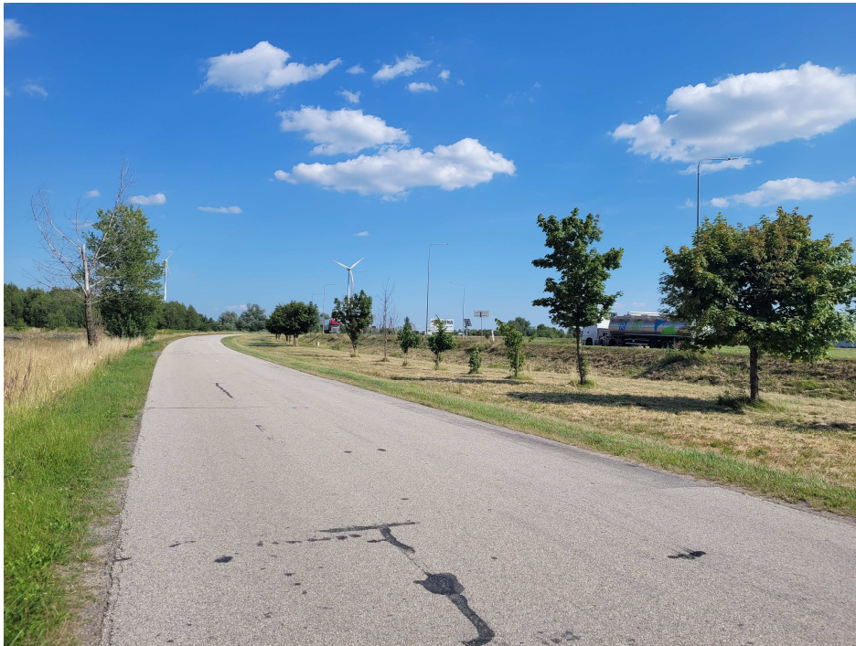
Fot. 5 Widok w kierunku wschodnim.
