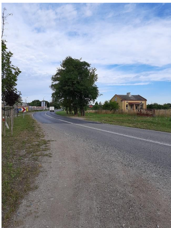
Fot.4. Widok z ul. Grójeckiej w kierunku zachodnim- widoczny budynek mieszkalny zlokalizowany w granicy planu (sierpień 2023).
