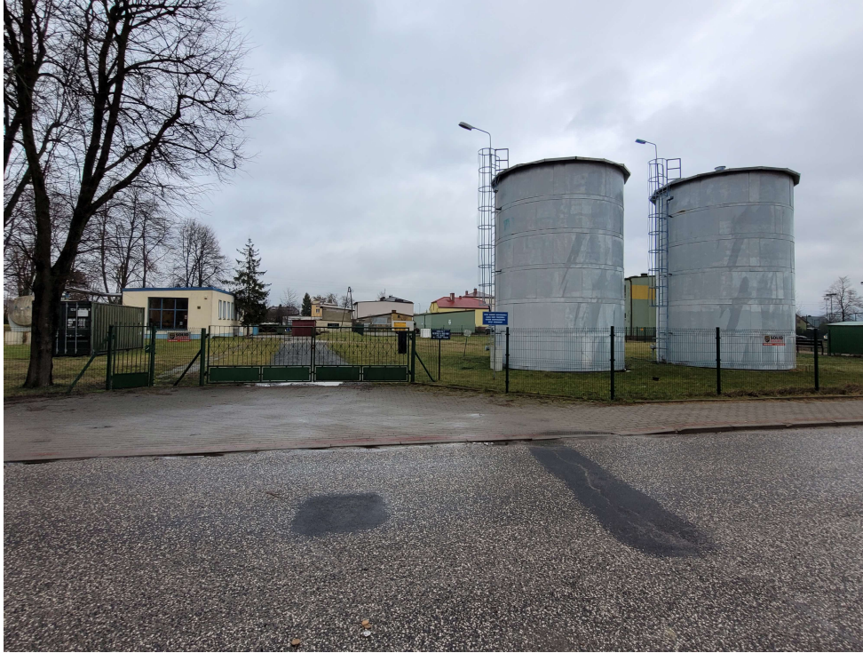
Fot.7. Ujęcie wody i stacja uzdatniania wody przy ul. Tysiąclecia.
