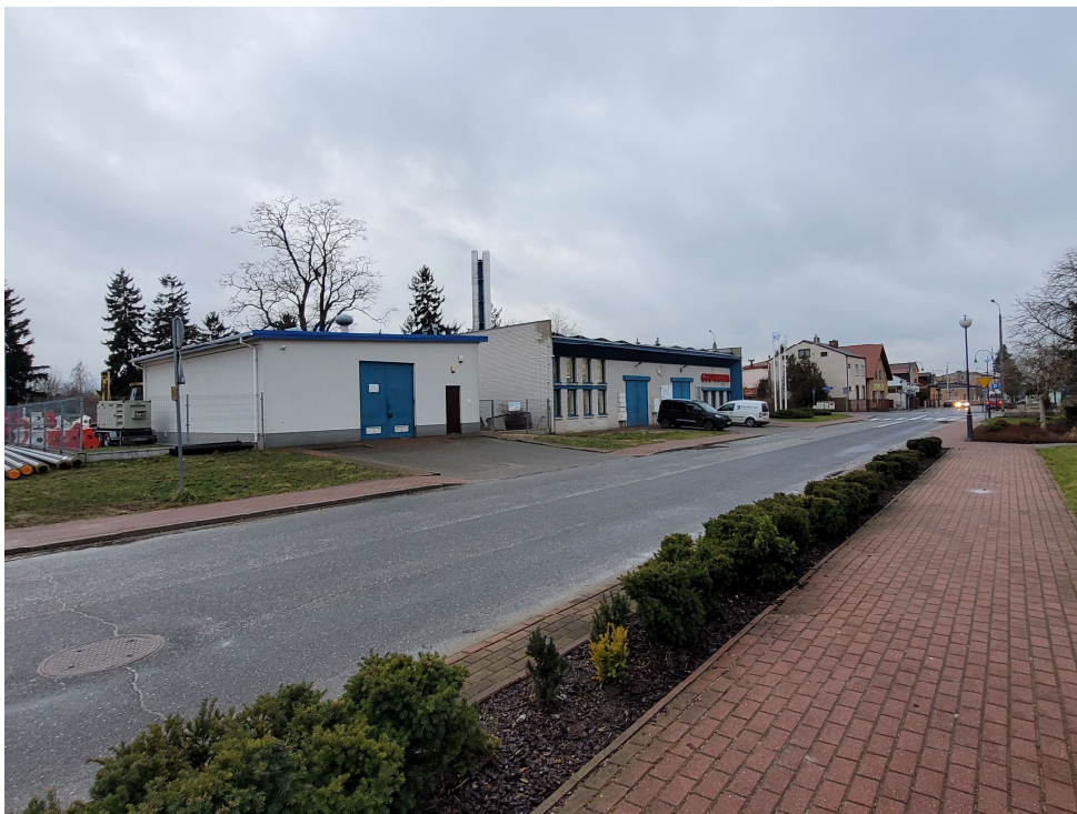
Fot.12. Geotermia Mazowiecka przy ul. Sienkiewicza.
