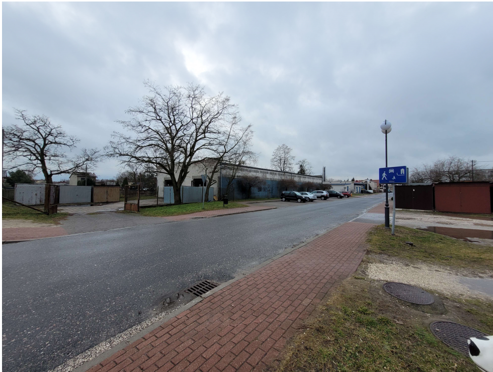
Fot.11. Budynek po kotłowni miejskiej przy ul. Sienkiewicza.
