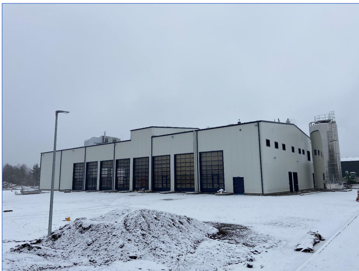
Rysunek 10 Hala produkcyjna z widocznym zbiornikiem 150 m 3 na wytwarzaną biomasę
