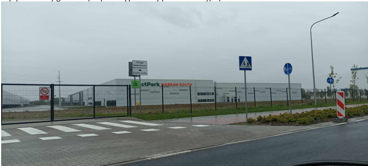
Fot.1. Centrum magazynowo-usługowo-logistyczne CTPark Warsaw South - widok od strony ul. Tarczyńskiej
