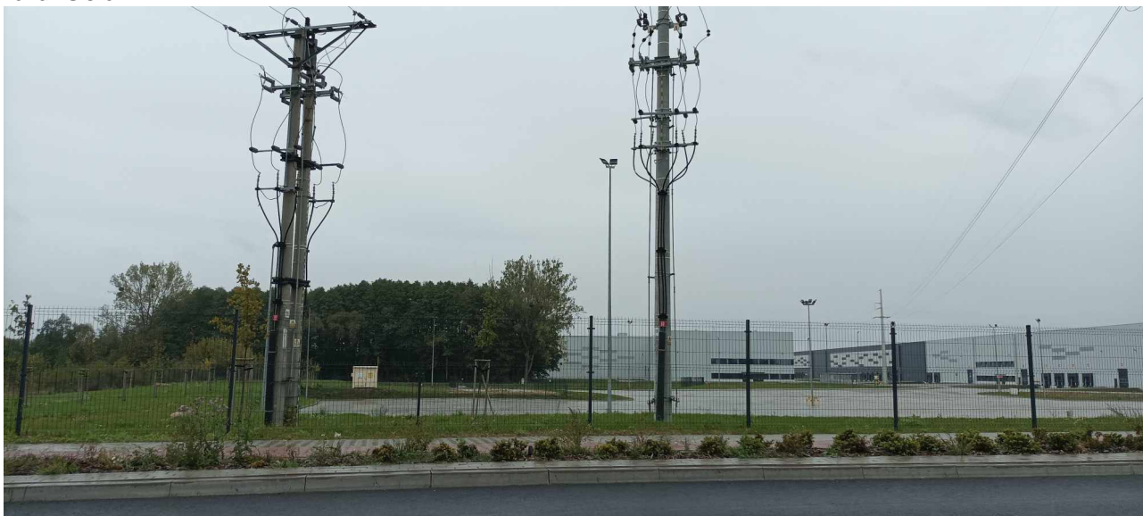
Fot. 6 . Przebiegająca przez obszar opracowania linia energetyczna wysokiego napięcia 110kV
