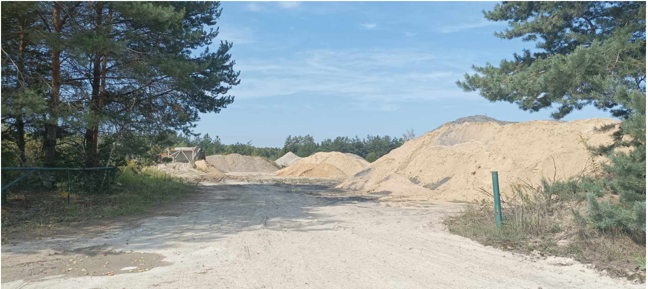
Fot.2. Północna część działki nr 65/5, ob. Zbizoża – miejsce składowania kruszywa
