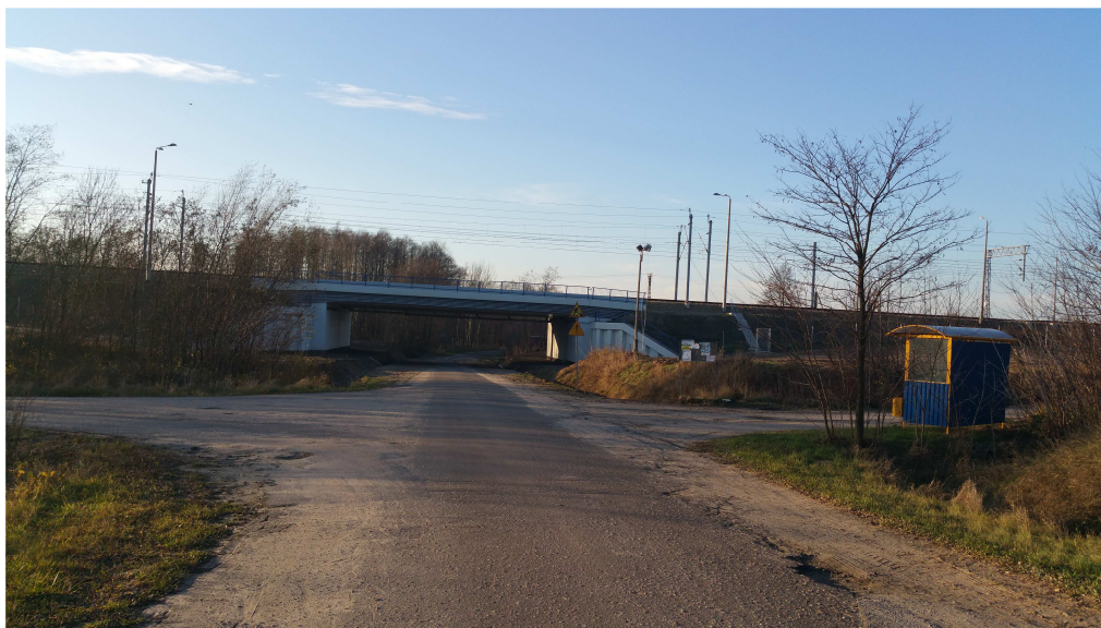
Fot.6. Wiadukt linii kolejowej CMK.
