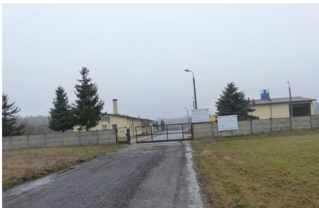
Zdj.7. Widok na zabudowę usługową – Zakład Gospodarki Komunalnej przy ul. Bocianie.
